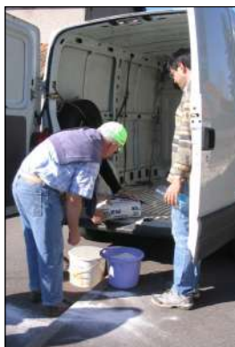
Répartition du plâtre entre les deux équipes de marquage.
